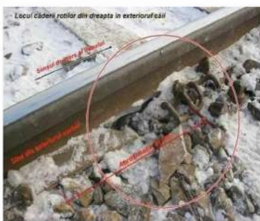
Foto nr.3 – punctul de reper „1”, ruptura tălpii șinei exterioare
