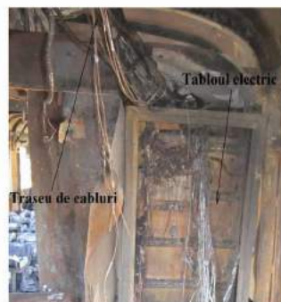
Fig.5 – Tabloul electric cu canal cabluri
