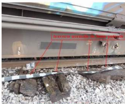
traverse normale de lemn, imediat după punctul „0”, în sensul de mers al trenului Foto nr.4
