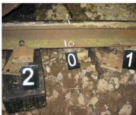
Foto nr.2 - detaliu punct „0” de cădere între firele căii
