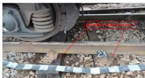
Foto nr.3 - prindere șină-traversă inexistentă
